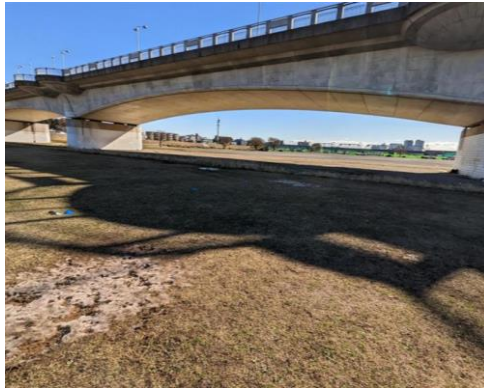
橋梁や橋脚下
